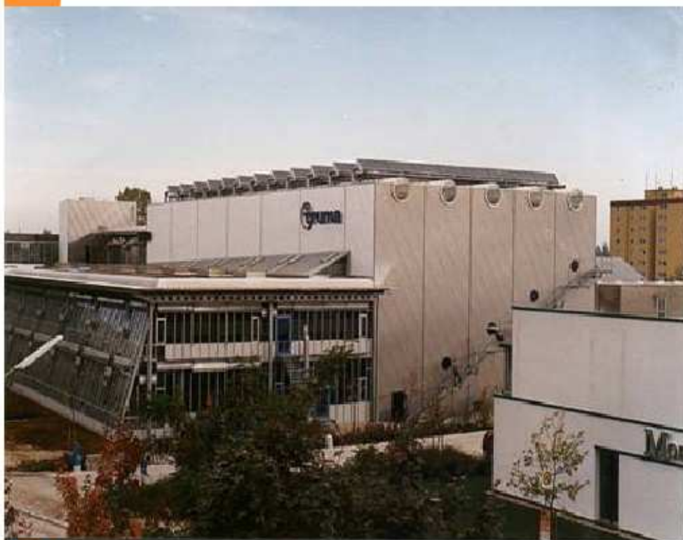
Magasin, Truma Putzbrunn, 210 m 2 de capteurs JumboSolar
